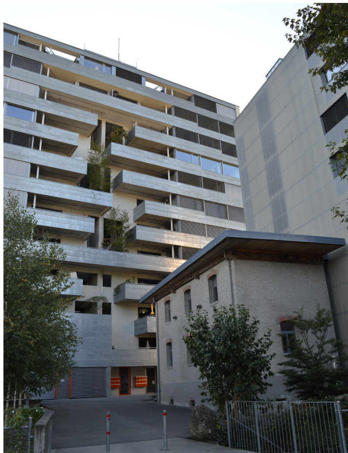
Sur la façade sud-ouest du silo, des loggias décalées les unes par rapport aux autres prolongent l'espace habitable. Photo: L. Buchmann, HSR
