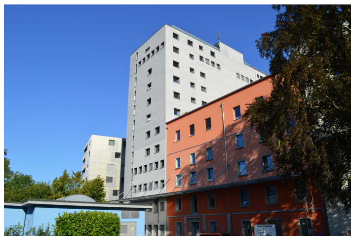
La façade sud-est ne présente que de petites fenêtres. C'est de ce côté que le moulin est accolé au silo. Photo: L. Buchmann, HSR
