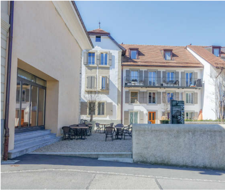
La démolition de l'annexe communale a permis de dégager la façade principale des trois bâtiments historiques (au fond). La salle à manger du restaurant (à gauche) dispose maintenant d'une vue sur la nouvelle place de la Broderie.
