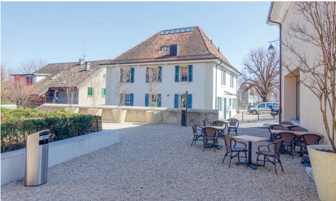
La nouvelle place de la Broderie crée un lien avec le château au fond et offre une terrasse protégée pour l'Auberge communale.
