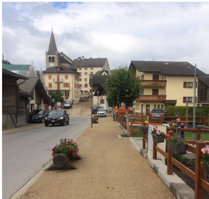
La zone de rencontre, au cœur du village, a été recouverte par un revêtement de couleur uniforme qui se prolonge sur le trottoir longeant la route principale, créant ainsi un lien entre les deux secteurs centraux, à savoir le centre historique et un deuxième centre plus commercial.
