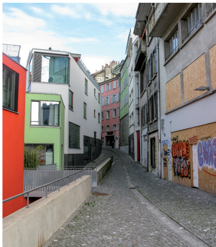
La rue du Rôtillon confronte les nouvelles constructions avec l'arrière des bâtiments historiques donnant sur la très chic rue de Bourg et figurant à l'ISOS.
