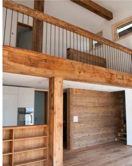
L'étable aujourd'hui. L'architecte Urs Nüesch a remis une grande partie des anciennes poutres à leur exacte position d'origine. À l'intérieur également, il a utilisé des éléments en bois de l'ancienne étable.
