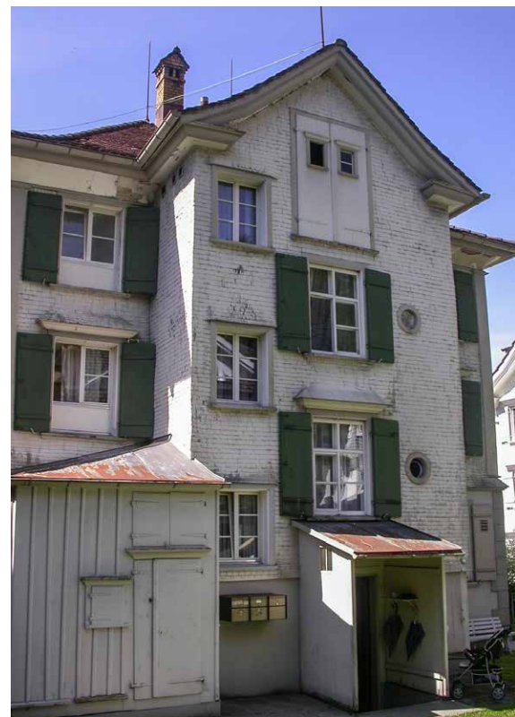
Les petites annexes ont été supprimées et remplacées par un abri pour les véhicules intégrant une terrasse. Photo: bm architekten eth sia
