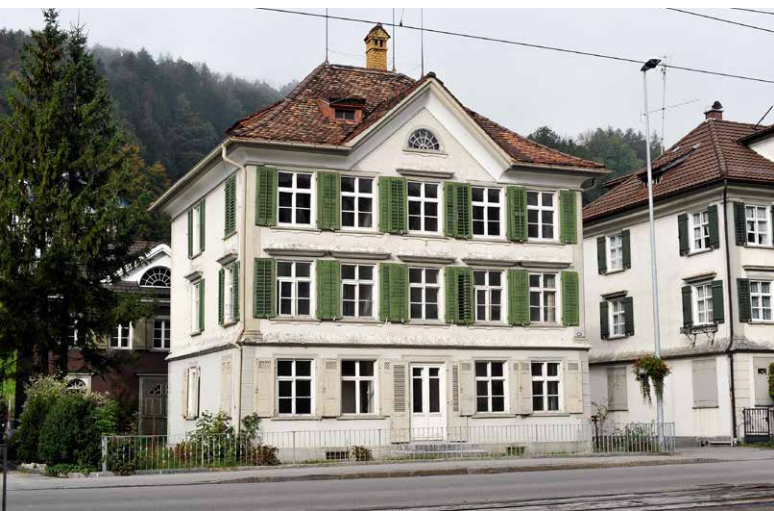
Ci-dessus – Dorfstrasse 82 à Bühler: Vue de profil avant transformations. Photo: bm architekten eth sia
