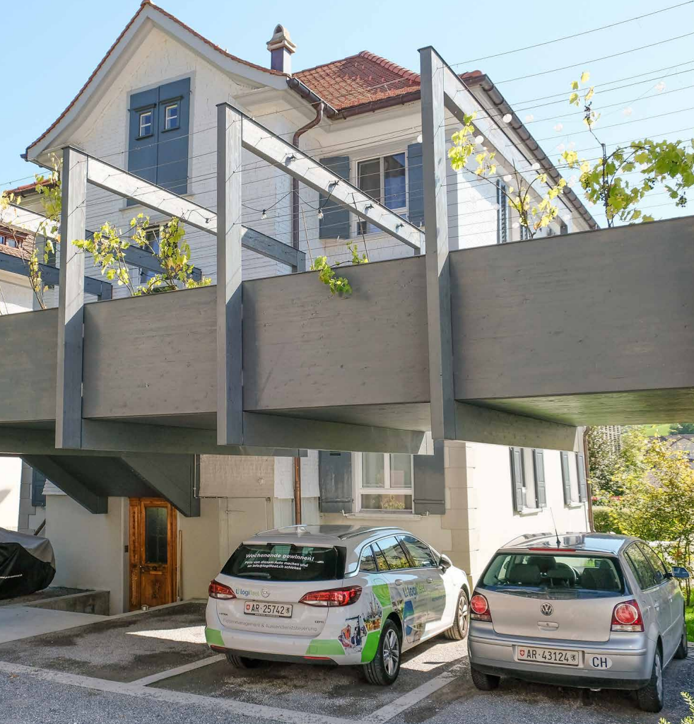
De derrière, on constate que l'abri pour les véhicules et la terrasse sont réunis. L'espace extérieur ainsi aménagé est attrayant. Photo: D. Steiner, EspaceSuisse
