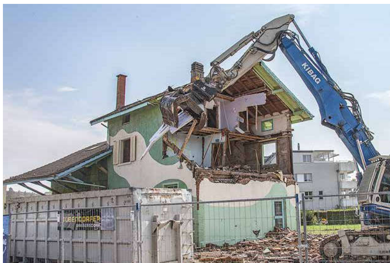
Im alten Bahnhof hatte sich die Jugend einquartiert. Für die Neugestaltung des gesamten Areals kam der Abrissbagger. Foto: Mano Reichling, ixedi.ch FOTOGRAFIE
