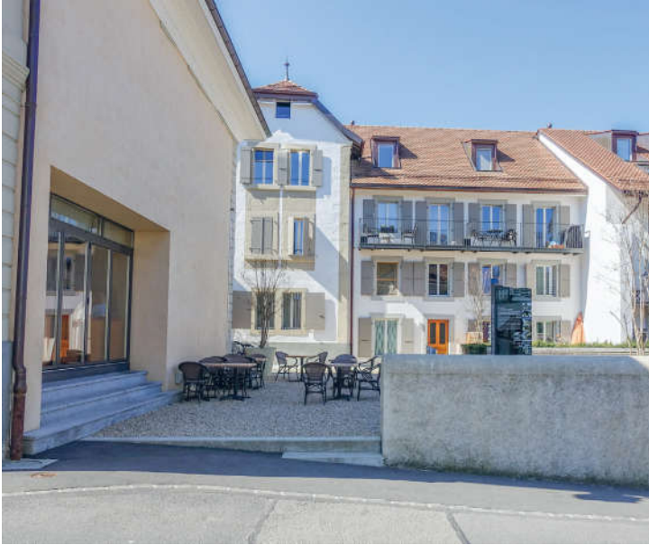
Durch den Abriss wurde der Blick auf die Hauptfassade der drei historischen Gebäude (hinten) freigelegt. Der Speisesaal des Restaurants (links) überblickt nun die neue Place de la Borderie.
