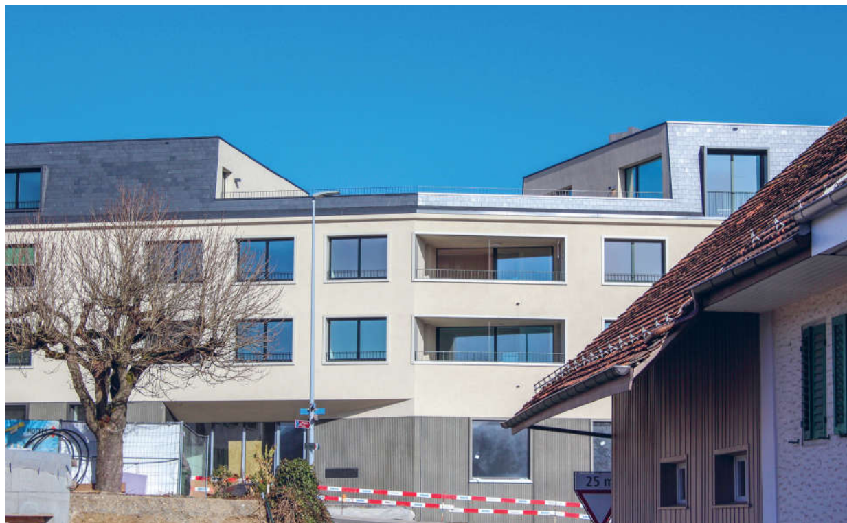
Anwohnerinnen und Anwohner befürchteten, dass das hohe Gebäude an der Mellingerstrasse den Verkehrslärm stärker reflektieren würde. Die Lösung: Der Mittelteil des Gebäudes wurde um ein Geschoss reduziert. Sein Dach dient den Wohnungen links und rechts als Terrasse. So verlor der Investor zwar eine Wohnung, konnte im Gegenzug dafür aber zwei aufwerten. Foto: R. Rieder, EspaceSuisse
