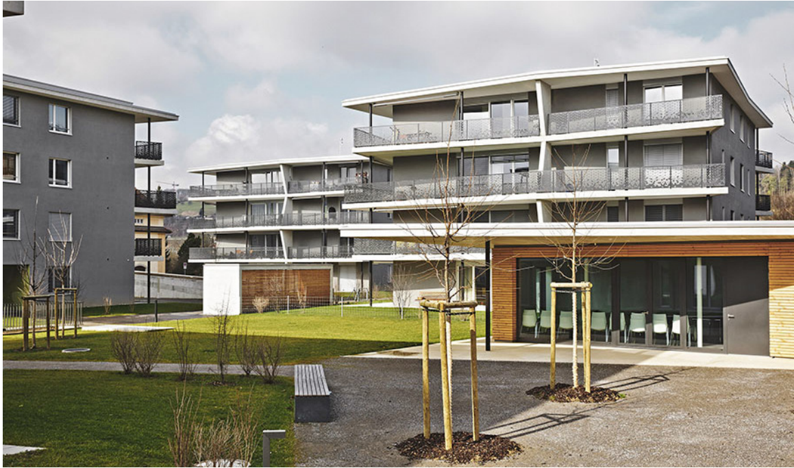
Mitten im Grün- und Aussenraum befindet sich der Pavillon (im Bild rechts vorne). Er dient allen Anwohnerinnen und Anwohnern als Gemeinschaftsraum und Begegnungsort. Foto: www.gross-ag.ch
