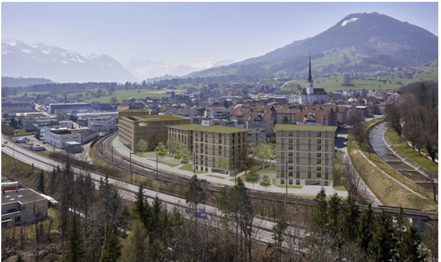
Die Visualisierung zeigt, wie die vollständig bebaute Allmend mit Pflegezentrum und Mehrfamilienhäusern aussehen wird. Foto: ro.ma. roeoesli & maeder GmbH
